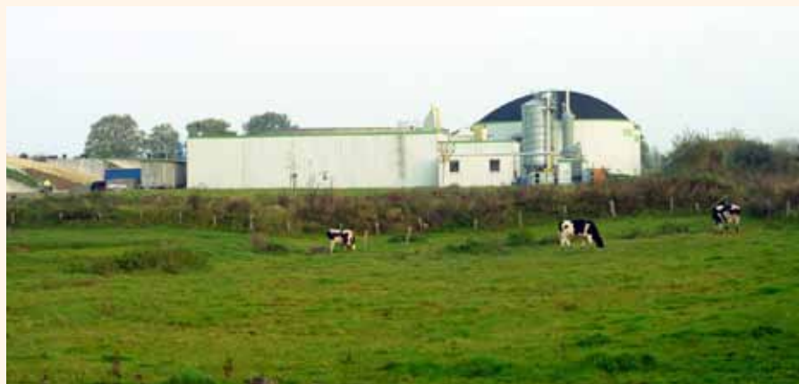
Biogasanlage in Honigsee / Foto: P.Pohlmann
