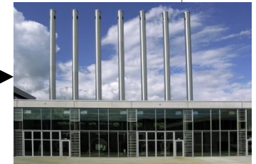
Energiezentrale Werk I
