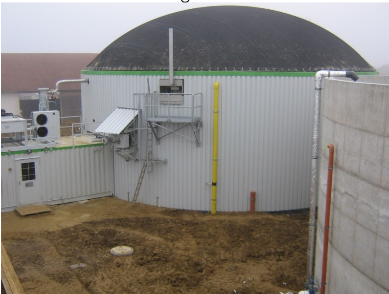
Die Biogasanlage des Betriebes Huber vor der Fertigstellung
